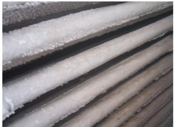
Ne discende quindi che diventa sempre più attuale non solamente prevedere l'installazione delle apparecchiature di trattamento dell'acqua previste dalla UNI 8065 (filtrazione, addolcimento, dosaggi additivi ecc.), ciò per evitare il presentarsi di fenomeni di corrosione ed incrostazione, bensì anche per prevedere una sanificazione/pulizia degli impianti già eserciti da tempo.
